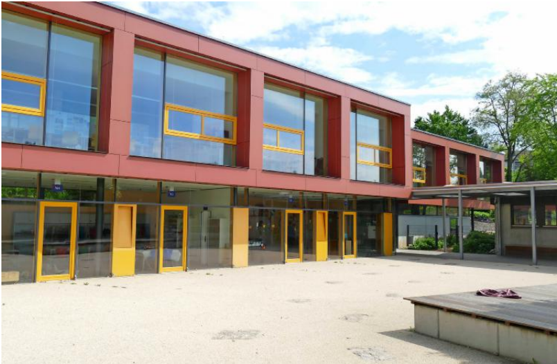
Der Lehrertrakt der Grundschule soll mit einer Klimaanlage ausgestattet werden. Im Sommer ist es dort extrem warm.
