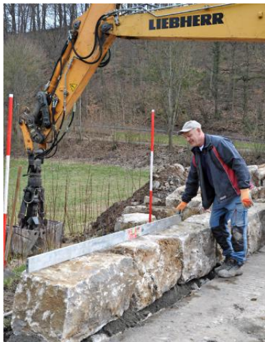
Am Riesenhof-Damm überwacht Alfred Zeller die Bauarbeiten. Fotos: Claudia Kostner
