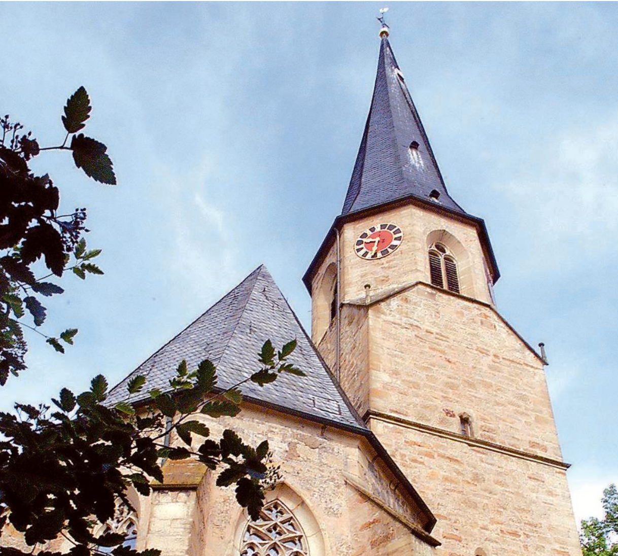
Die Außensanierung und die Instandsetzung des Dachs der St.-Cyriakus-Kirche sind abgeschlossen. Mehr als eine halbe Million Euro wurde in das Projekt gesteckt. Die Kirchengemeinde ist froh über zahlreiche Zuschussgeber.
