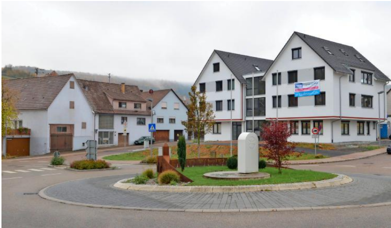
Im Untergeschoss des neuen Gebäudes am Kreisverkehr hat die Gemeinde Praxisräume gekauft, um die hausärztliche Versorgung zu sichern.
