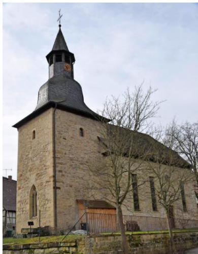
Die Sankt-Jakobus-Kirche wird voraussichtlich ab dem Frühjahr saniert.
