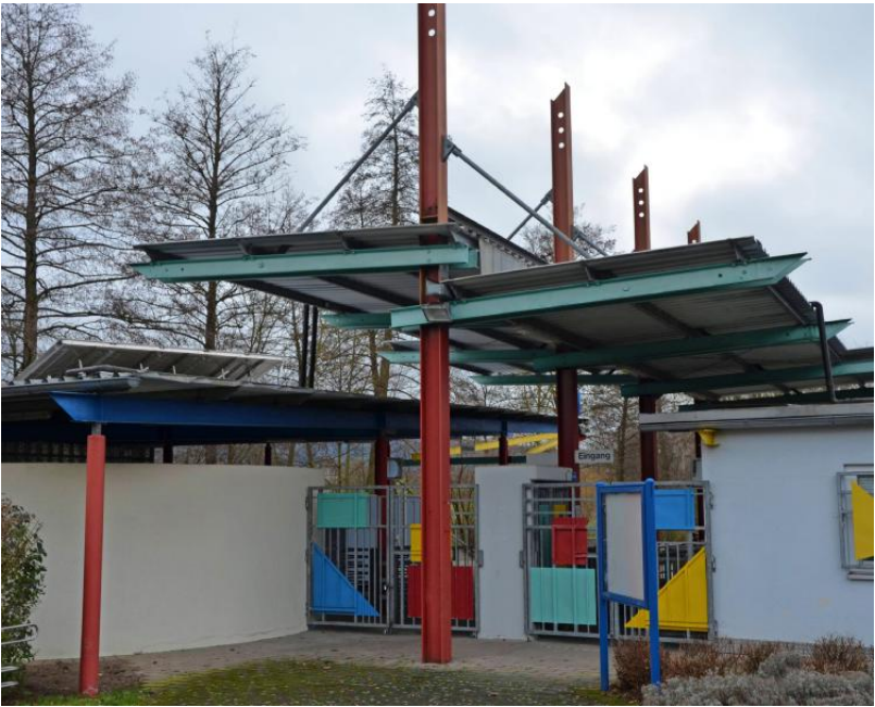
Das Freibad in Güglingen erhält ein neues Kassensystem. Dann soll über die Toranlage registriert werden, wie viele Gäste rein- und rausgehen.
