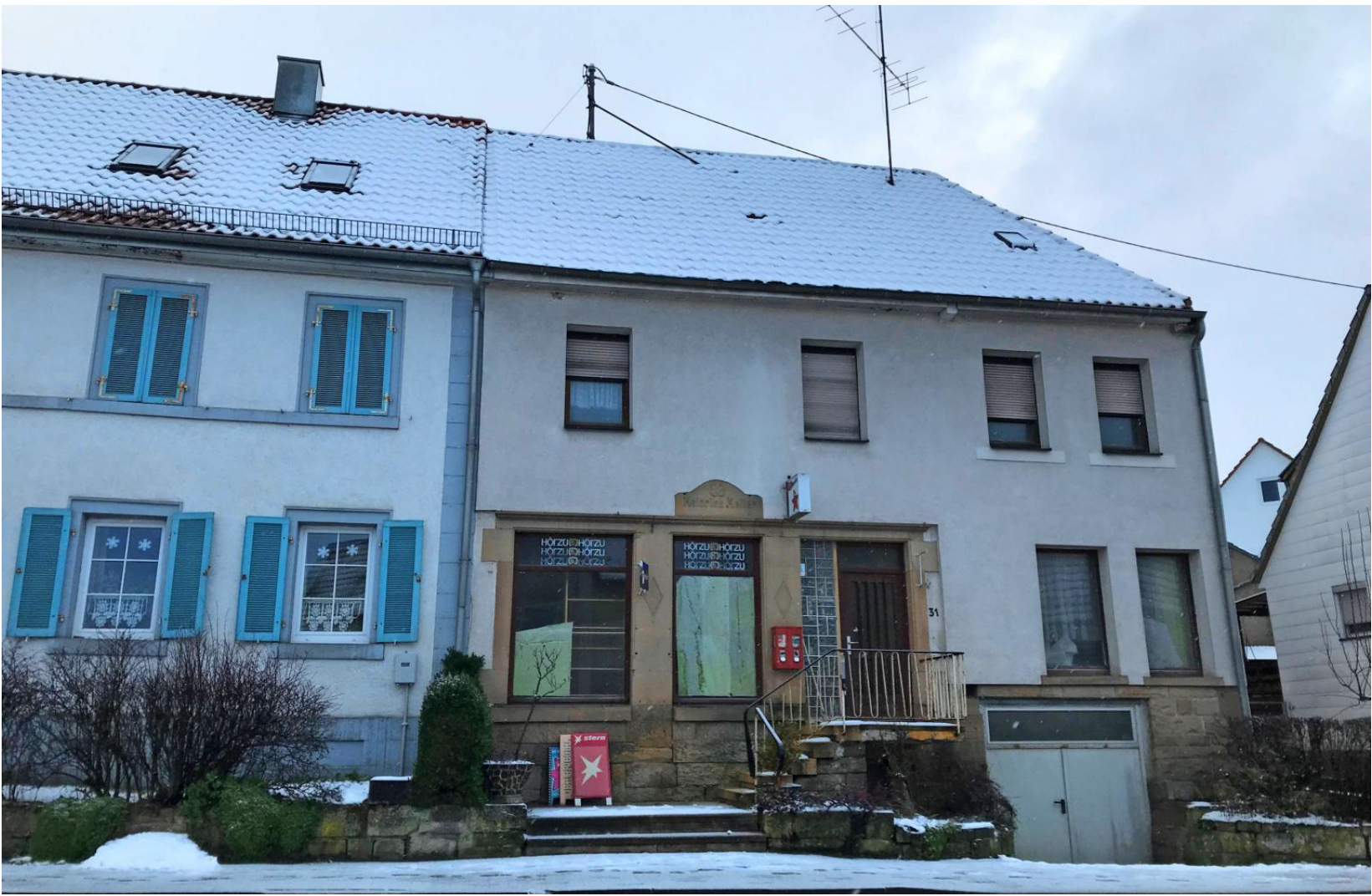
Zwei Gebäude in der Leonbronner Straße hat Diana Kunz für das Wohnprojekt vorgeschlagen. Dort sollen mehrere Wohnungen entstehen.
