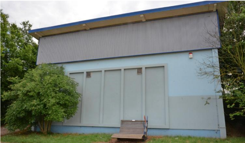
Im Wasserhochbehälter „Katzensteige“ wird das Wasser aus den vier städtischen Brunnen mit derzeit 50 Prozent Bodenseewasser vermischt. Foto: Josef Staudinger
