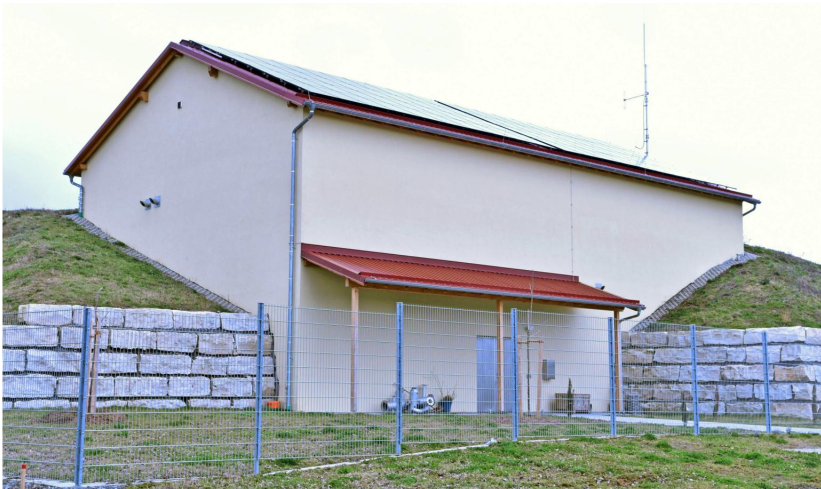
Das Herzstück des neuen Wasserversorgungskonzeptes ist der neue Hochbehälter bei Ochsenburg.
