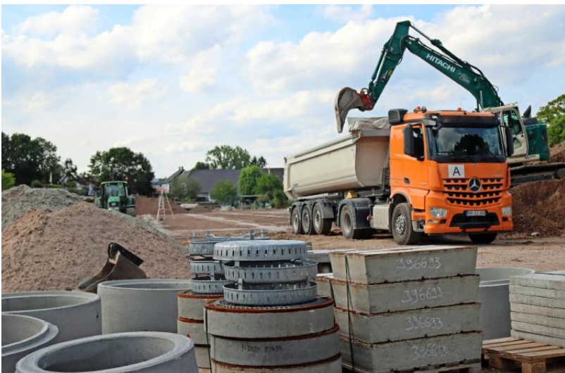
Das Stadion in Massenbachhausen wird umgebaut und generalsaniert. Nach der Sommerpause 2022 soll der Sportplatz wieder bespielbar sein.
