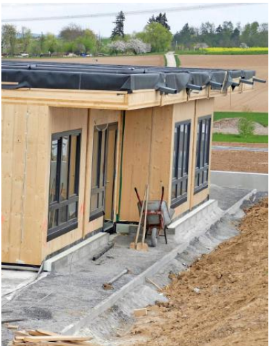
Bisher ist die Hälfte der Module für die Kita Nahweg aufgestellt.
