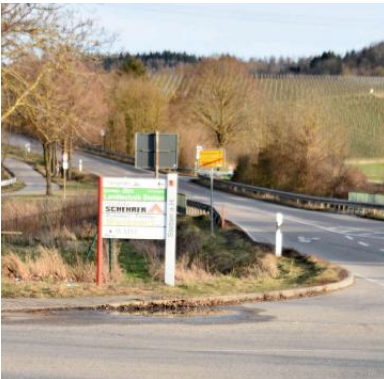
Von Stetten Richtung Niederhofen wird der Radweg ausgebaut.
