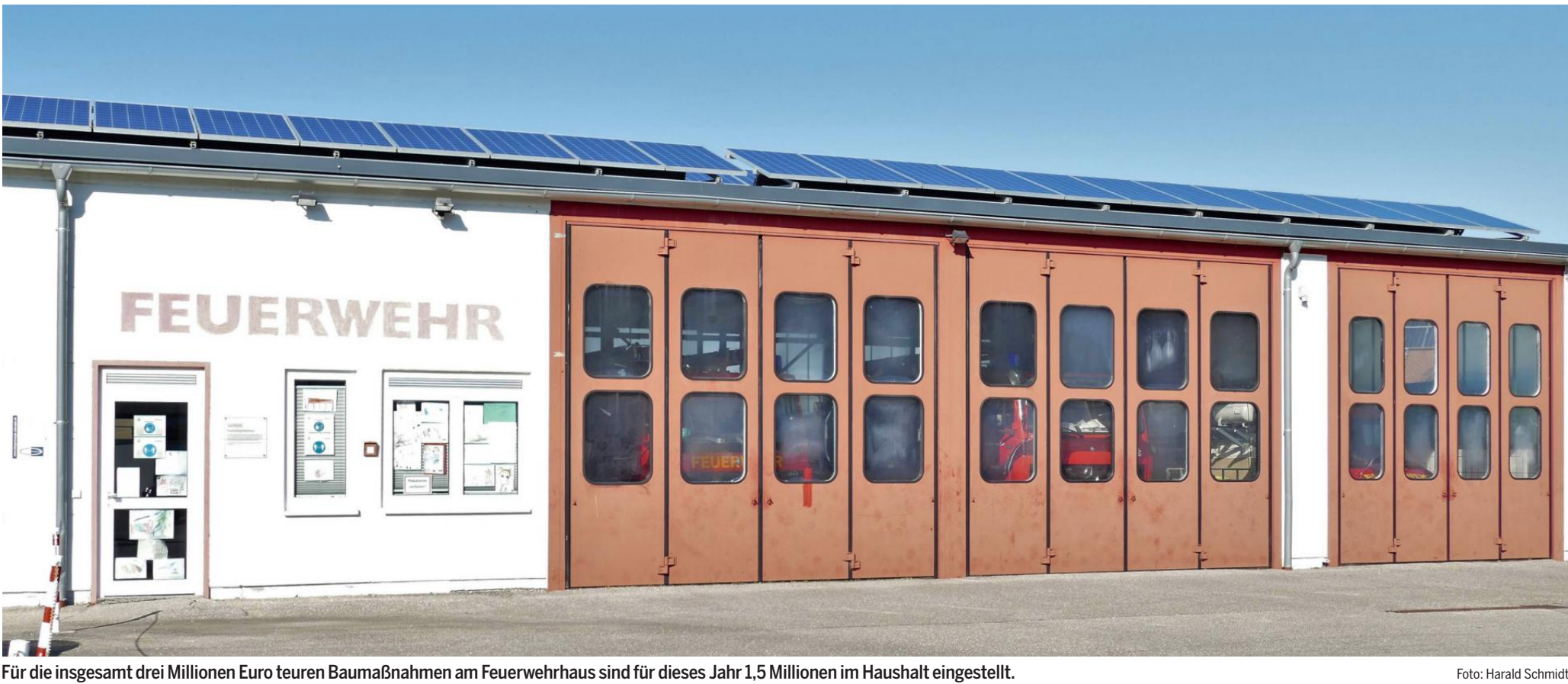
Für die insgesamt drei Millionen Euro teuren Baumaßnahmen am Feuerwehrhaus sind für dieses Jahr 1,5 Millionen im Haushalt eingestellt.
